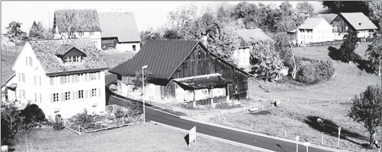
Die schöne alte Scheune hat man absichtlich verlottern lassen – in der Hoffnung, sie abreißen zu dürfen.
