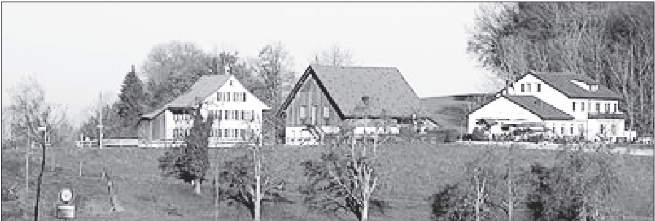
Die Restaurants Chnusperhüsli (links) und Buchenegg (rechts) sollen abgebrochen werden.
